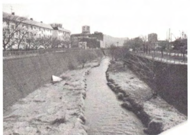
写真一五 鍛冶橋の下流部（旧願乗寺川）
