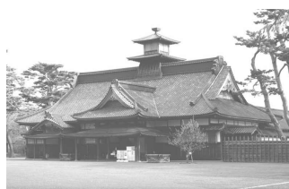
五稜郭内の「箱館奉行所庁舎」
